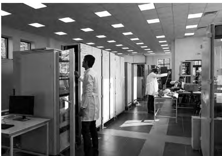
Монтаж технических средств автоматизации
