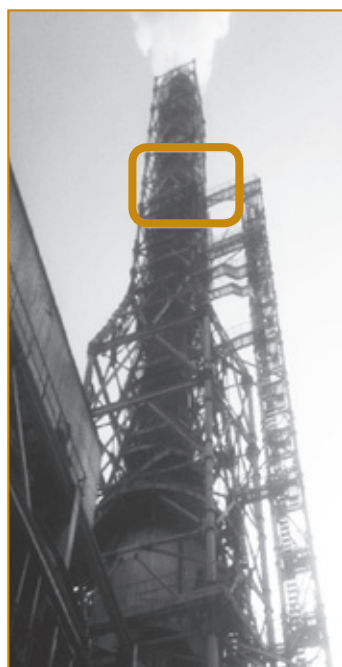
АИС установлен на отметке 64 метра
