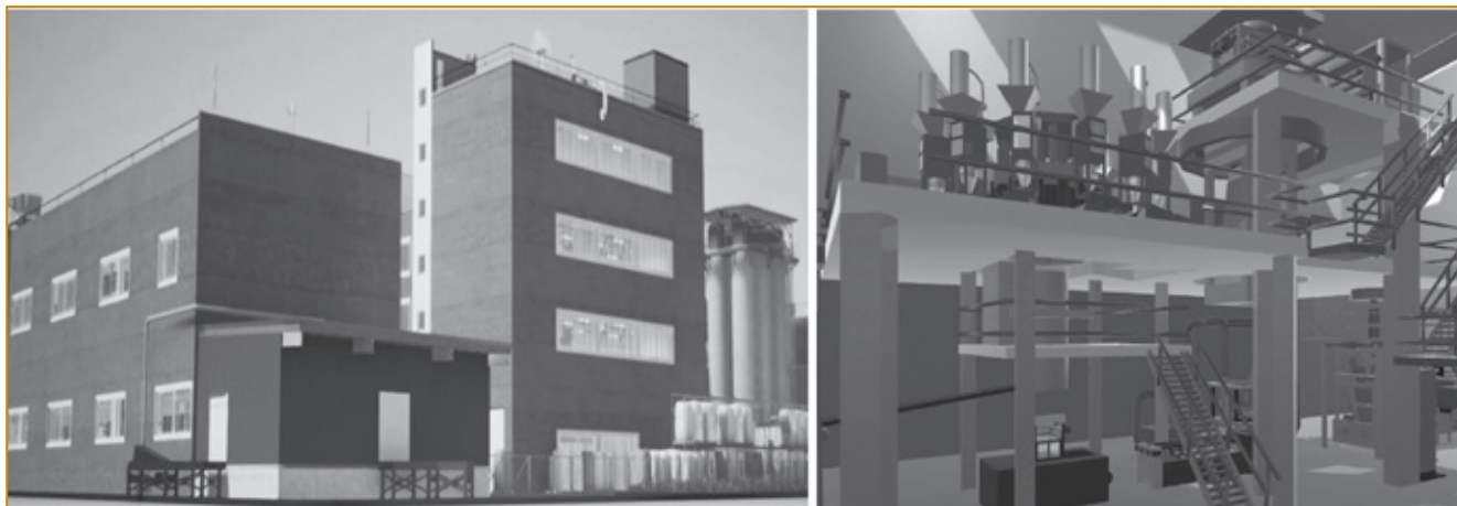
Рис. 5. Виртуальные модели завода по производству каландрированных полимерных материалов (Санкт-Петербург) и экструзионной линии для изготовления 11-слойных рукавных полимерных пленок (Германия)
