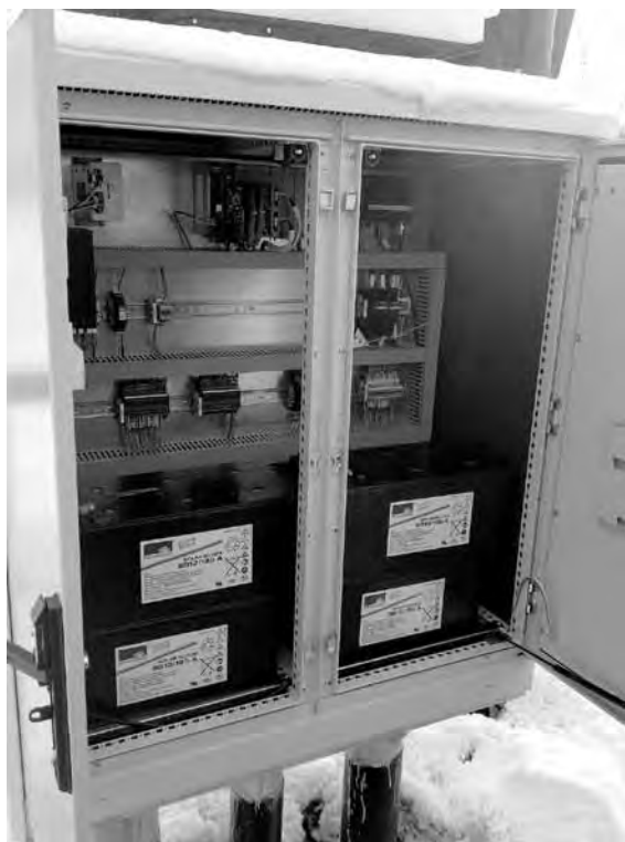
Рис. 5. Конструкция контролируемого пункта телемеханики
