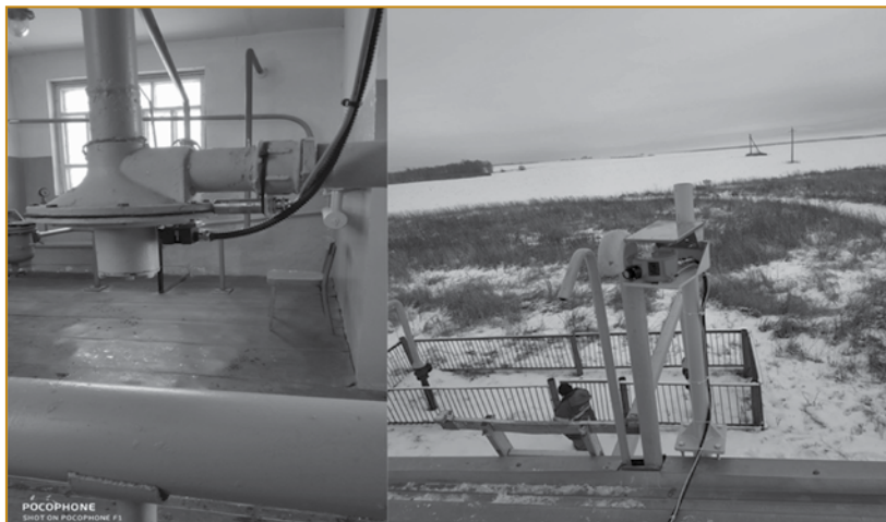
Рис. 2. Установка оборудования на ПСК и сбросной свече
