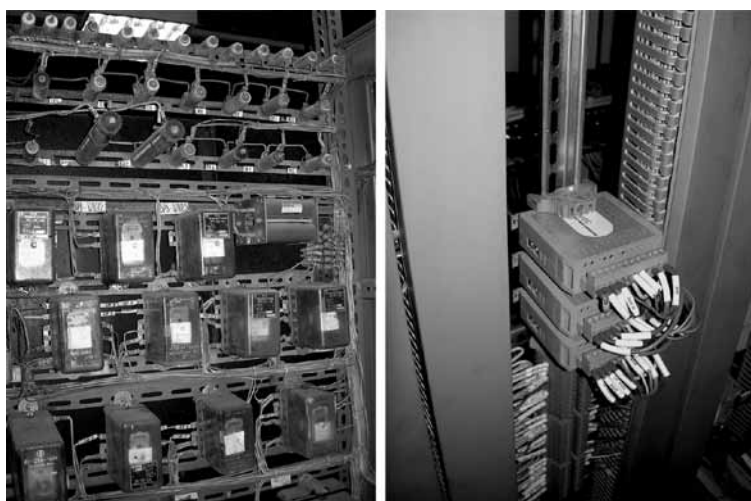
Рис. 3. Внешний вид старой, релейной и электронной с CUV-DC схем управления тремя ИПК к/а
