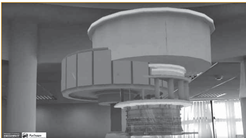
Рис. 4. Планирование процесса демонтажа на примере гидроагрегата Волжской ГЭС, спроектированной АО «Институт Гидропроект»
