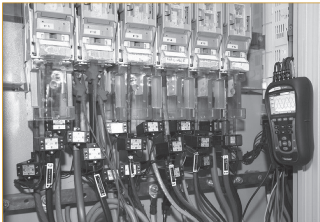
Рис. 1. Инструментальное обследование оборудования электрических сетей
