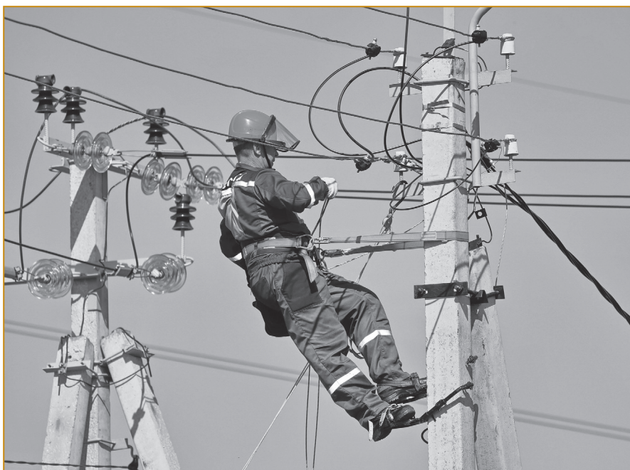
Рис. 1. Работа полевых бригад электросетевых компаний
