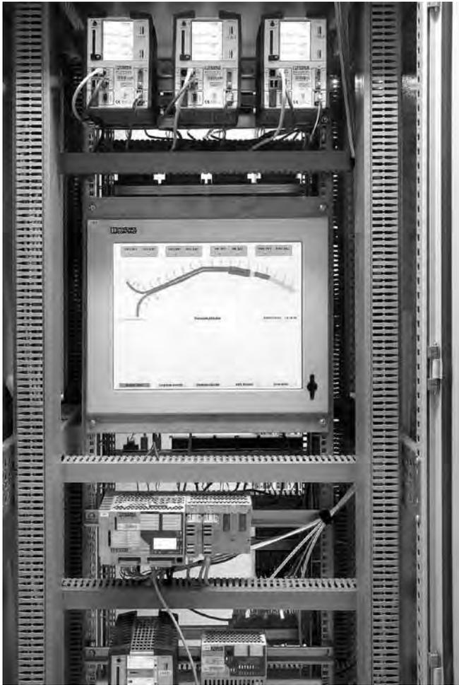
Рис.3. Центральный шкаф управления аварийной сигнализацией
