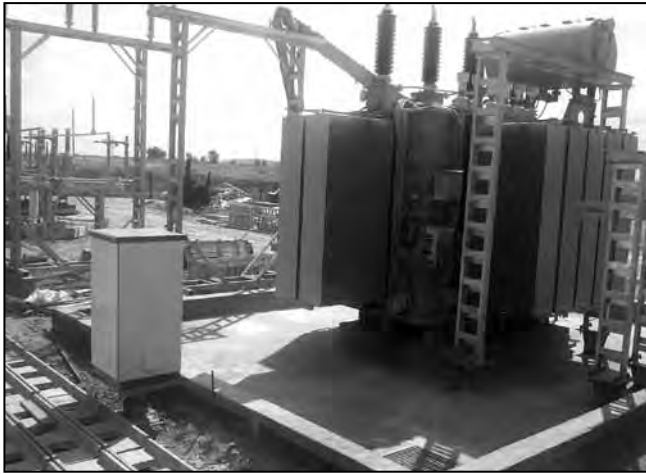
Рис. 2. Шкаф СУМТО на ОРУ 110 кВ Сакмарской СЭС
