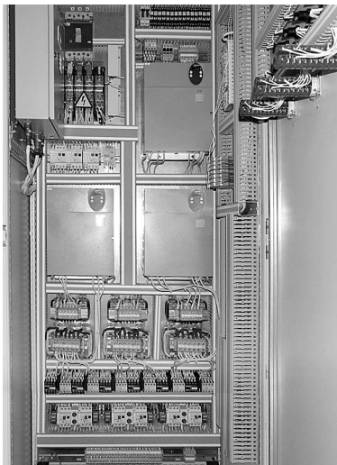
Рис. 3. Шкаф НКУ с частотными преобразователями и контроллером вибрации
