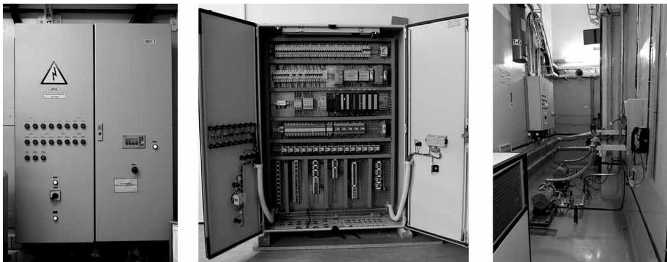
Рис. 3. Шкаф управления внешний вид, конструкция и размещение на объекте
