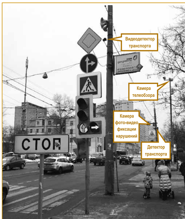
Рис 1. Объекты ИТС на отдельном перекрестке. Существующее положение
