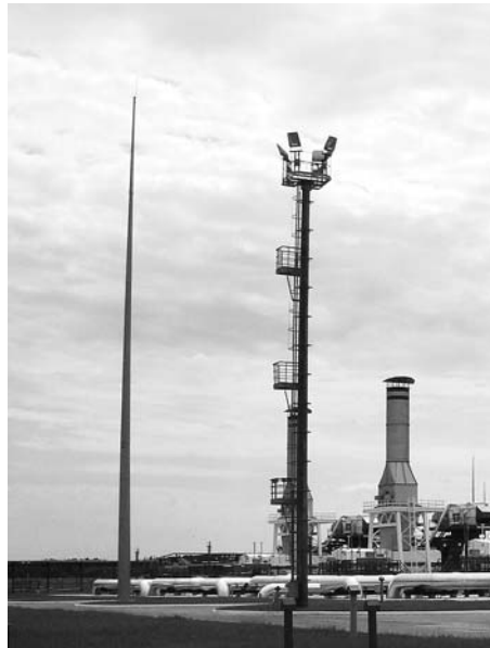
Рис. 2. Прожекторная мачта на площадке КС
