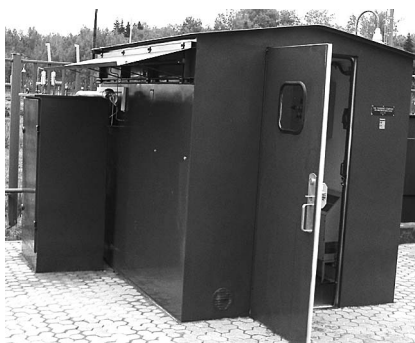
Рис. 1. Блок-бкс с потоковым хроматографом
