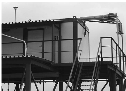
Рис. 3. Воздухозабор с избыточным давлением
