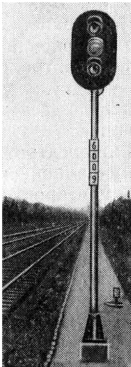
Рис. 2. Проходной линзовый светофор
