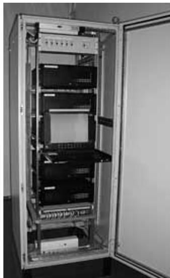
ПТК "Торнадо" является открытой системой, что позволило интегрировать в АСУТП оборудование других производителей: локальную систему мониторинга микропроцессорных защит блока генератор-трансформатора на аппаратуре НПО "ЭКРА" и станцию мониторинга системы возбуждения генератора на аппаратуре фирмы "Энергоцветмет", микропроцессорные терминалы электрических защит распределителей 6 кВ производства фирмы "Механотроника" (Москва), а также подсистему пирометрического контроля факела в топке котла.
