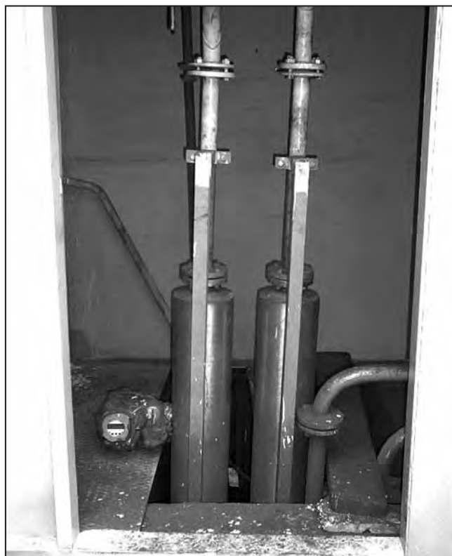
Рис. 2 Измерение плотности шлама при сложных производственных условиях в металлургической промышленности двумя приборами OPTIMASS 7000 – T40
