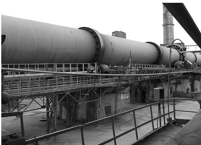
Рис. 3. Применение тепловизионной системы в производстве цемента (г. Балаклея, Украина)
