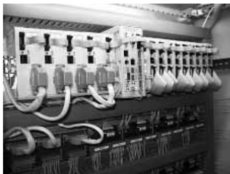
Рис. 2. Контроллерная часть шкафа управления
