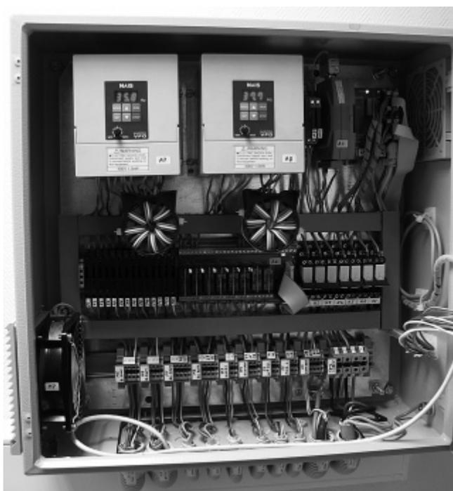
Рис. 5. Самодельные подавительные дроссели в шкафу управления двигателями системы вентиляции (размещены непосредственно под преобразователями частоты Matsushita VFO)
