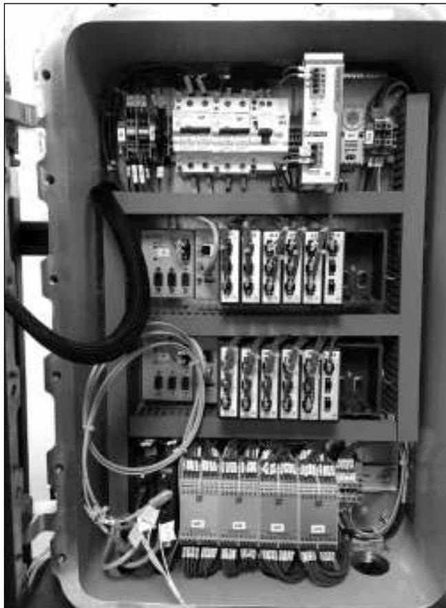
Рис. 4. Пример монтажа оборудования во взрывозащищенную оболочку, для установки во взрывоопасной зоне II
