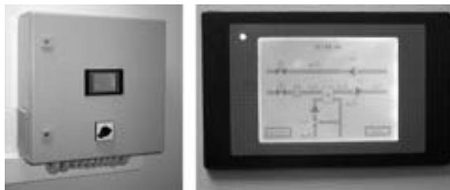
Рис. 2. Графическая панель CIMREX 41 с сенсорным экраном на пульте управления централизованной системой вентиляции в офисе заказчика (разработка ООО "ЭФО", С.-Петербург)
