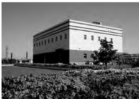
Рис. 1. Здание Единой операторной ООО «ЛУКОЙЛ-Волгограднефтепереработка»
