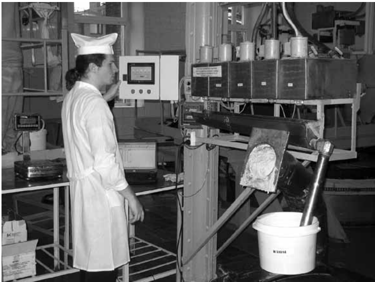
Рис. 7. Процесс тестирования и отладки системы управления временной МСД
