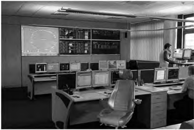
Рис. 2. Помещение серверной рудника
