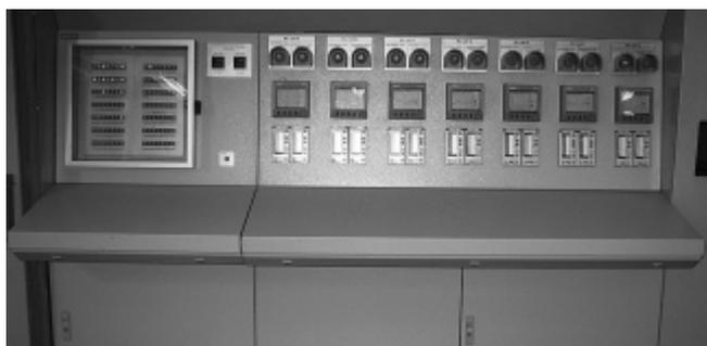
Рис. 2. Резервные щитовые средства контроля и управления
