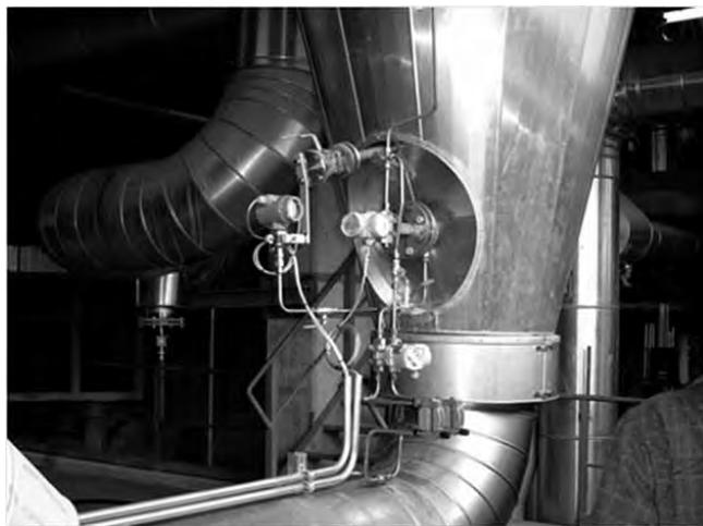
Рис. 4. Сенсор ERS высокого давления, установленный внизу резервуара
