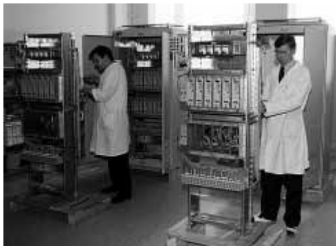
Рис. 1. Монтаж стоек ТПТС
