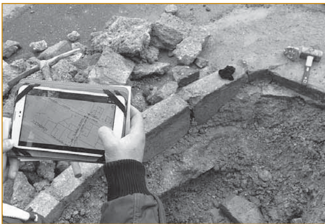
Рис. 3. Мобильная технология помогает полевым бригадам точнее позиционироваться на местности и получить нужную техническую информацию, что позволяет быстрее и более эффективно устранять неисправности в сети
