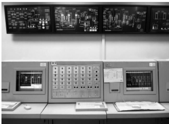
Рис. 1. Внешний вид мнемосхемного комплекса из четырех плазменных панелей
