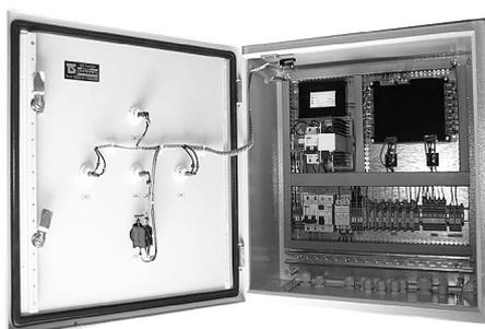
Рис. 2. Блок управления транспортом сыпучих материалов
