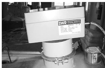
Рис. 4. Измерение расхода сыпучих материалов в аэрожелобах расходомером SlideControl
