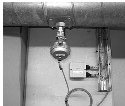
Рис. 8. Контроль исправности фильтров датчиком пыли Dusty
