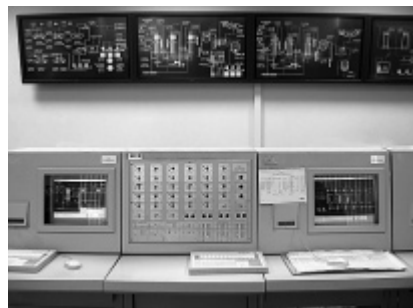
Рис. 2. Внешний вид мнемосхемного комплекса из четырех панелей
