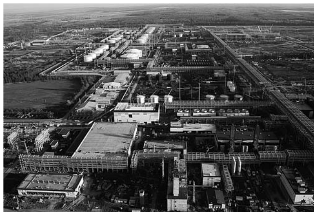
Рис. 1. Строительная площадка комплекса — вид сверху
