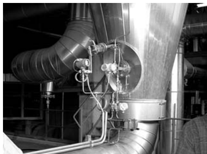
Рис. 2. Сенсор ERS высокого давления, установленный внизу резервуара
