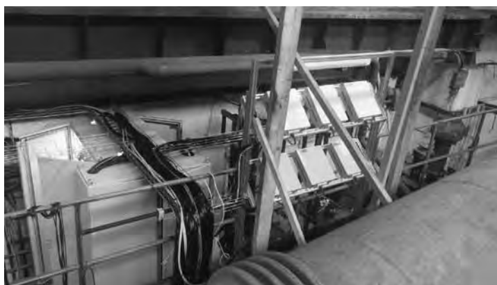
Рис. 5. В процессе реконструкции: сканеры температур и приборные шкафы НПП «МЕРА» на стенде НИЦ ЦИАМ
